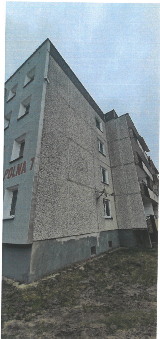
Polna 7 ściana wraz z bokiem loggi od strony ul. Komara.
